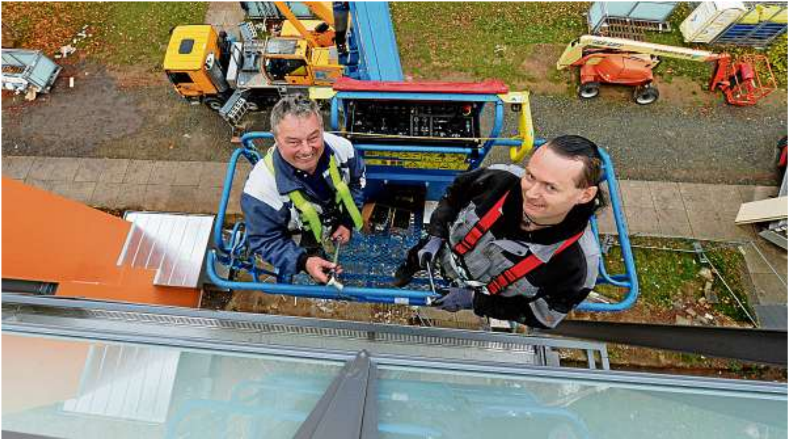
Uwe Fritzsche (links) von der gleichnamigen Firma und sein Mitarbeiter Udo Heuschkel montieren in rund 12 Metern Höhe die Geländer für die sogenannten Laubengänge in Gera-Lusan. Fotos (2): Peter Michaelis
