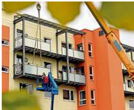
Aufwendige Montage an der Fassade.
