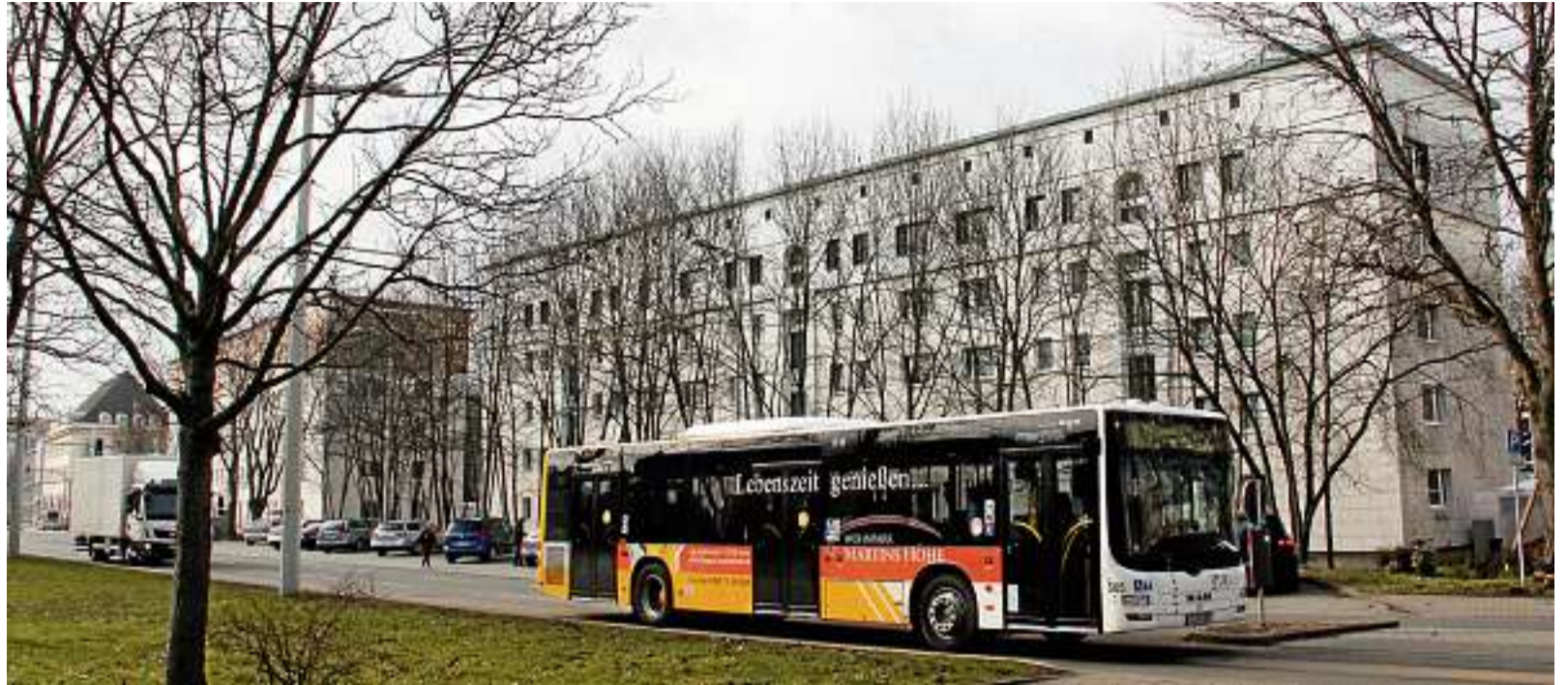
Der Block rechts wird im 2. Bauabschnitt im kommenden Jahr saniert. Im Wohnhaus links daneben haben die Arbeiten bereits begonnen, unter anderem werden drei Erdgeschoss-Wohnungen zu einer barrierefreien Zahnarztpraxis umgebaut. Fotos (2): Marcel Hilbert/Plan: WBG Glück Auf Gera
