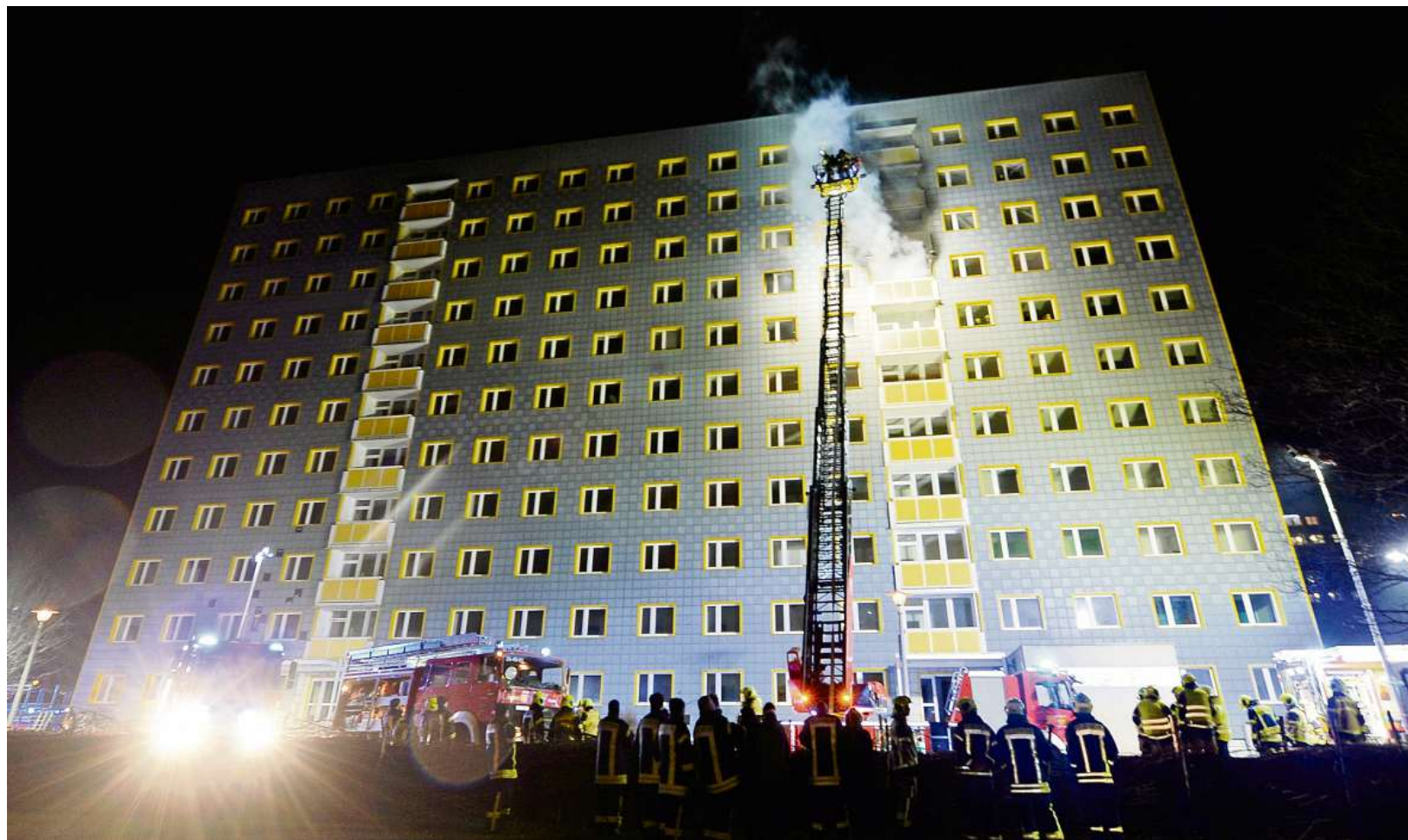
Der Wohnblock bei der Feuerwehrübung am 3. Januar. Das seit August 2019 leergezogene Haus soll bald abgerissen werden.
