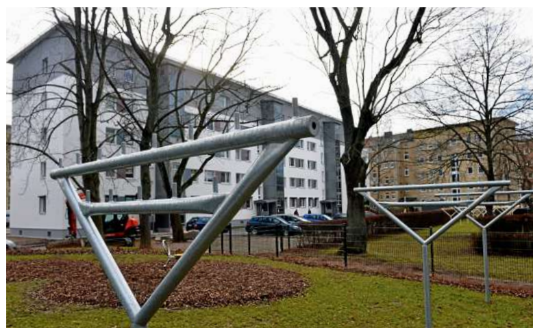
Die Wohnungsbaugenossenschaft hat in der Reichsstraße und dem Anna-Schneider-Weg insgesamt drei Wohnblöcke barriere-reduziert saniert und als teilgeschlossene Wohnanlage gestaltet. FOTOS (2): PETER MICHAELIS
