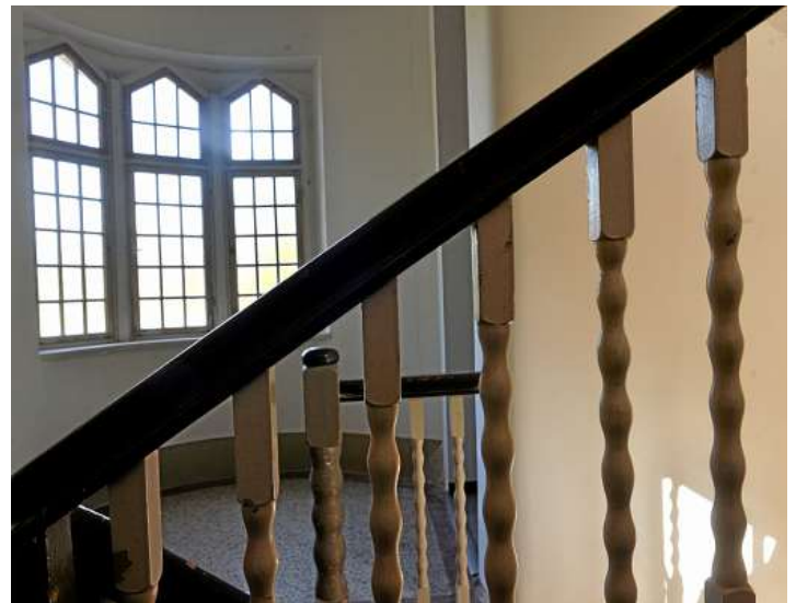
Blick ins Treppenhaus mit originalen Fenstern und Treppengeländern vom Ende der 1920er Jahre.
