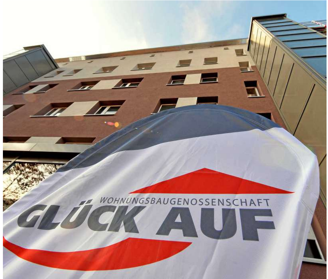
Ein komplett saniertes Haus der Wohnungsbaugenossenschaft in der Reichsstraße.
