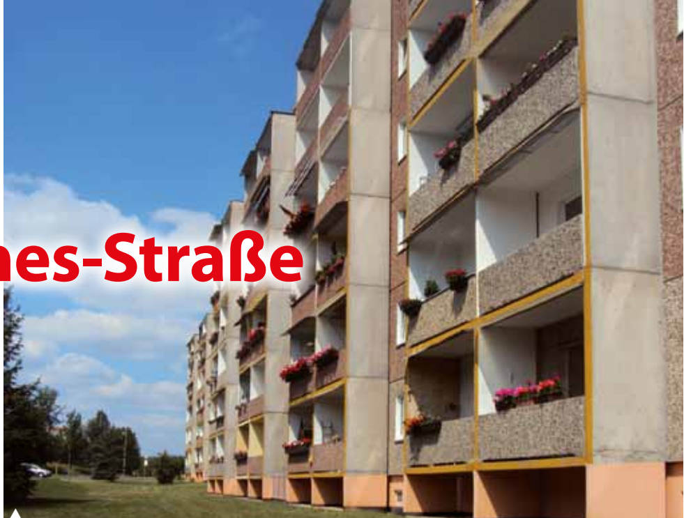
▲ Der Beginn der Umbaumaßnahmen erfolgt in den beiden Häusern Karl-Matthes-Straße 69 – 83, ▲ hier hat die Planung zu den umfangreichen Baumaßnahmen bereits begonnen
