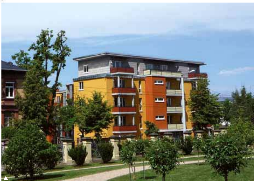
▲ Das Baugerüst ist entfernt, nun ist der Blick frei auf die harmonische Farbgebung der Fassade und die großzügigen Balkone und Terrassen
