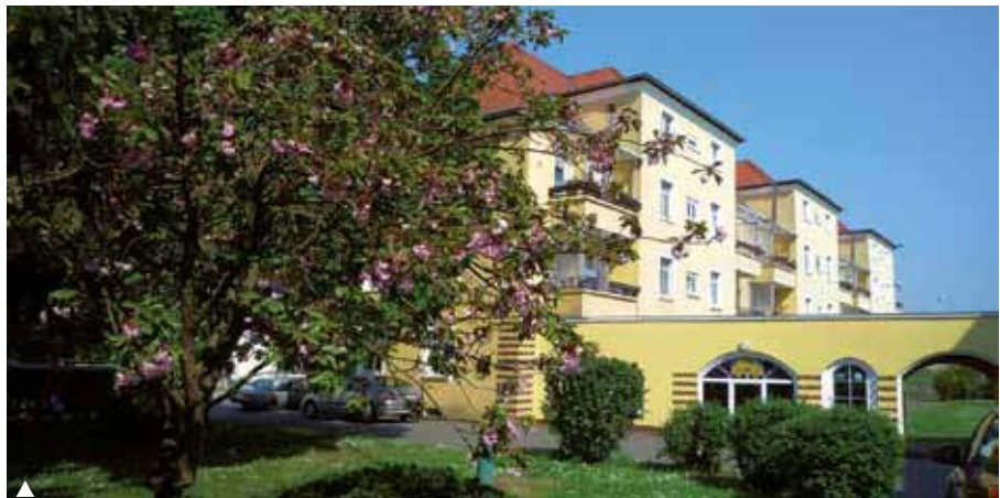
▲ Häuser im Bestand der GWG (Bilder von oben): ▲ Grüner Weg (Bieblach, Tinz), ▲ Gagarinstraße (Stadtzentrum), ▲ Uhlstraße (Lusan)
