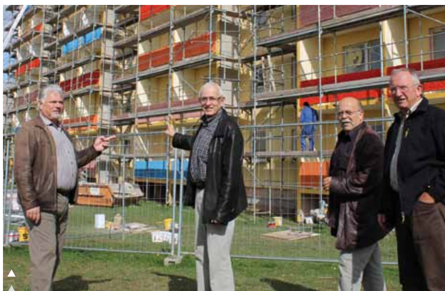
▲ Auch der Aufsichtsrat der „Glück Auf“ besuchte die Baustelle, um sich vor Ort ein Bild von den umfangreichen Sanierungsarbeiten zu machen.
