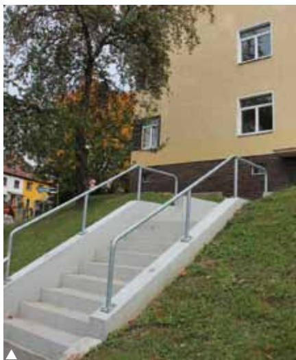
▲ Bild oben: die neue Zufahrt in der Brehmstraße ▲ Bild unten: bereits im vergangenen Jahr wurde die Treppe zum Hauseingang erneuert
