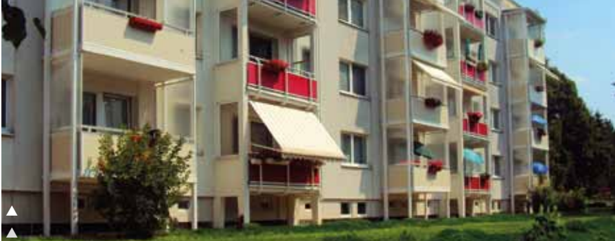
▲ Wie hier im Erzhammerweg 2 bis 6 wurde in diesem Jahr in mehreren Wohngebäuden die Erneuerung der elektrischen Anschlüsse und Anlagen fortgesetzt.
