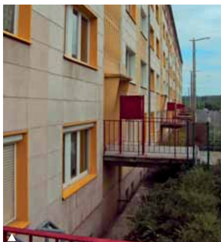
▲ Berliner Straße 203 – 211, ▲ hier wird der Zugang zu den Häusern erneuert
