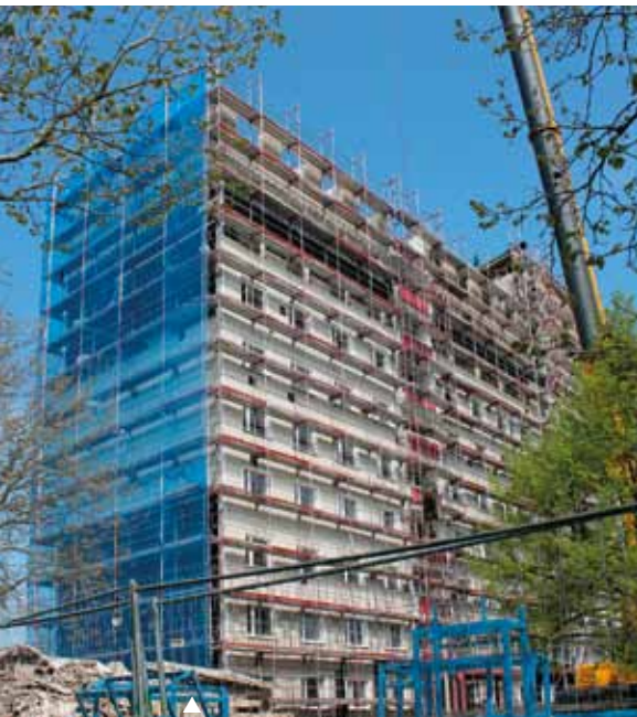
▲ Durch den Abbruch des Elfgeschossers in der Weidenstraße entsteht eine großzügige Freifläche
