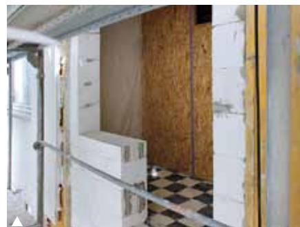
▲ Um die Zugänge zu den neuen Balkonen herzustellen, mussten die Wohnzimmeraußenwände komplett abgebrochen werden. Staubschutzwände schützten den dahinter liegenden Teil des Wohnzimmers.
