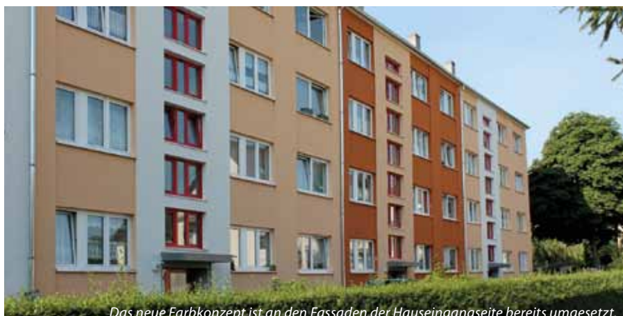
Das neue Farbkonzept ist an den Fassaden der Hauseingangsseite bereits umgesetzt.
