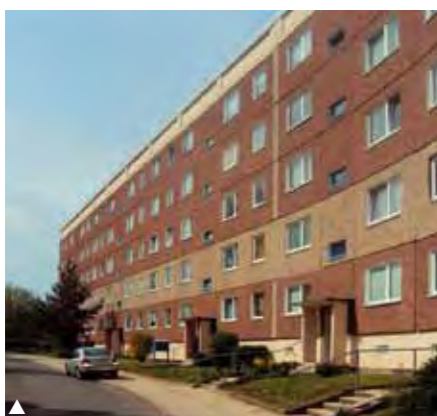
▲ Neben neuen Wohnungseingangstüren erhält unser Haus in der Otto-Worms-Straße unter anderem ein neues Dach
