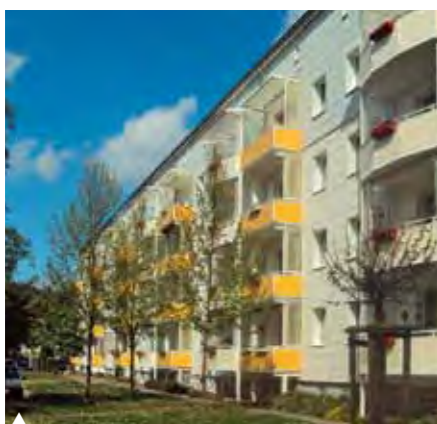
▲ In der Heinrich-Zille-Straße wird die Gasanlage erneuert
