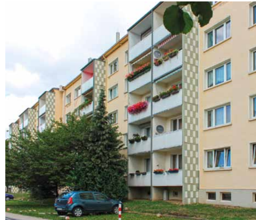
Niemöllerstraße 1 – 9 (Archivaufnahme), das Haus ist bereits leergezogen, die Vorbereitungen zum Umbau im kommenden Jahr haben bereits begonnen
