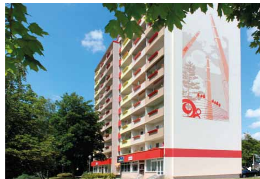
◀ In diesem Jahr erfolgt die Dachsanierung in der Berliner Straße 150 – 156.
