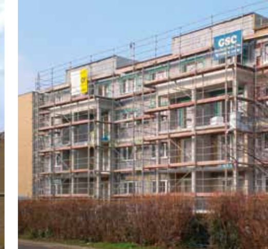
Auch Etagen wurden zurück gebaut
