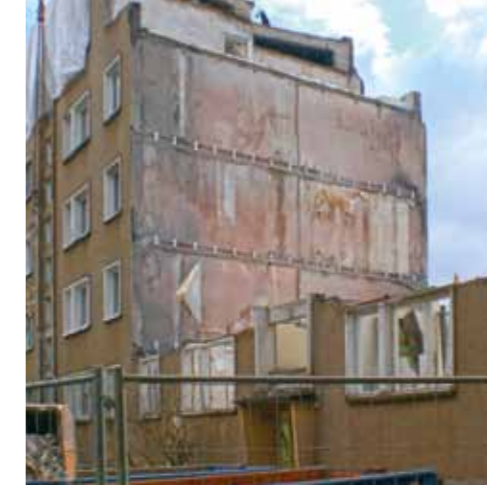
Einzelne Eingangsbereiche wurden abgerissen
