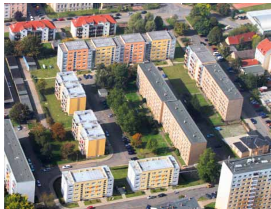
Schon im 1. Bauabschnitt kam es durch Abrisse und Rückbau bei der Sanierung zu sichtbaren Veränderungen im Wohnensemble.
