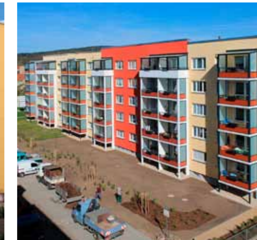
Ein gepflegtes Wohnumfeld wurde geschaffen
