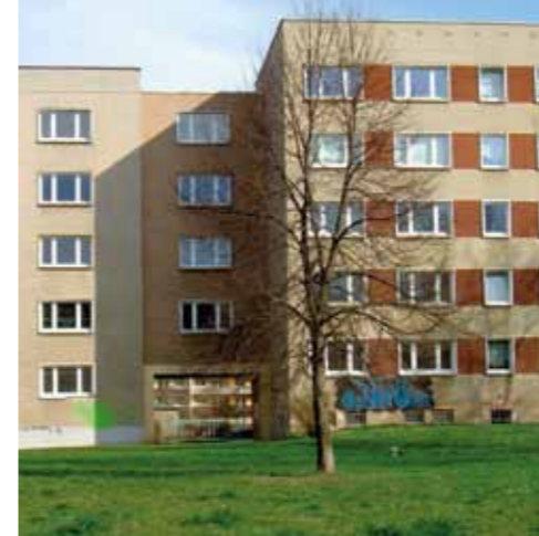
Grau-braune Wohnblöcke im Ur-Zustand
