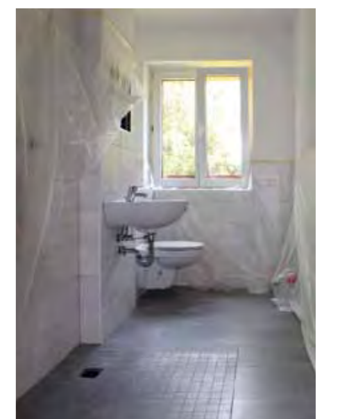
▲ Das Bad wurde komplett saniert, es konnte dadurch aber auch nicht mehr benutzt werden. Eine ebenerdige Dusche, neue Sanitärkeramik, moderne Fliesen – das neue Bad ist fast fertig.
