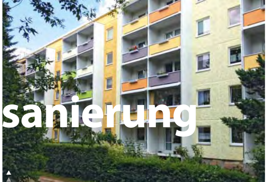
▲ Die Rudolstädter Straße 25–35, hier sind die Bauarbeiten fast abgeschlossen, es fehlen nur noch die Balkonbrüstungen zu den Mietergärten
