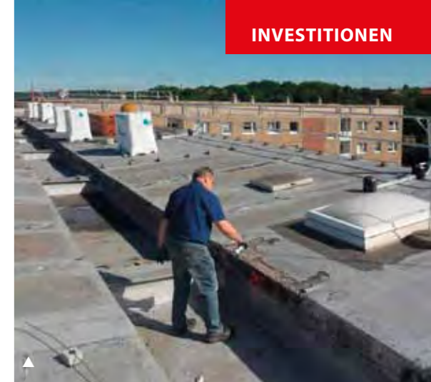
▶ Dacheindeckung und neuer Blitzschutz auf den beiden Eilgeschossern in der Berliner Straße
