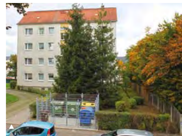
▶ Bild oben: Treppenhaus in der A.-S.-Makarenko-Straße Bild unten: Containerstellplatz in der Levenstraße
