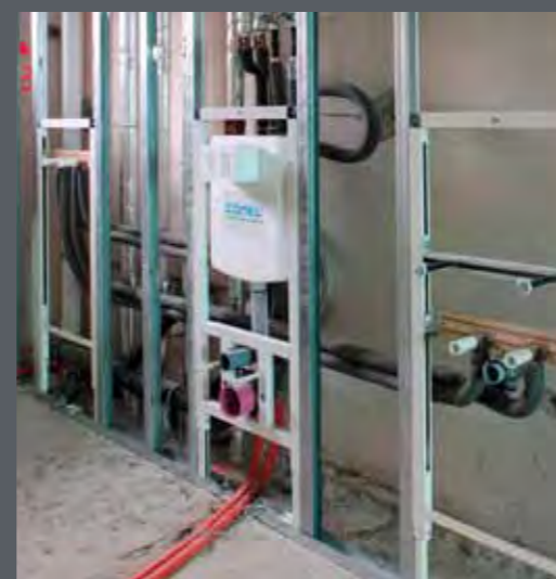
Ständerwände für Badinstallationen
