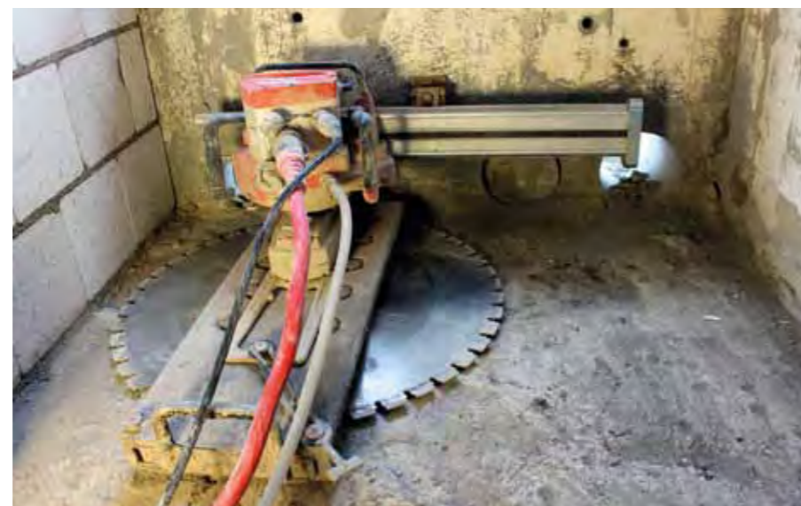
Starkes Gerät durchtrennt die dicken Betonmauern der Außenwände
