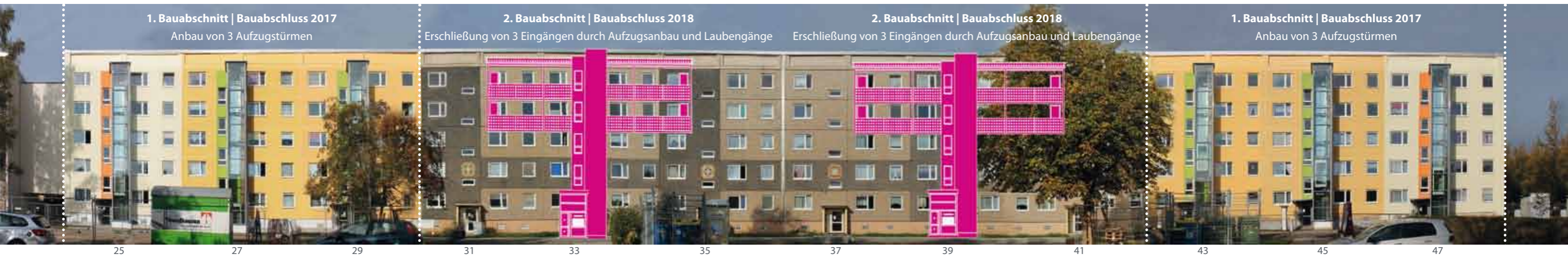
Aufzugsanbau in der Rudolstädter Straße
