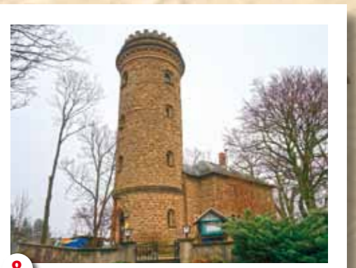
8 ... zum Ferberturm, hier links abbiegen und 100 m weiter den Zschippernerweg bergab, ...
