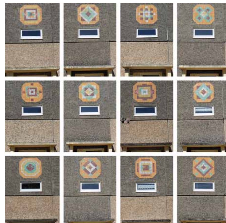
Jedes Mosaik wurde 1977 im Plattenwerk individuell gestaltet
