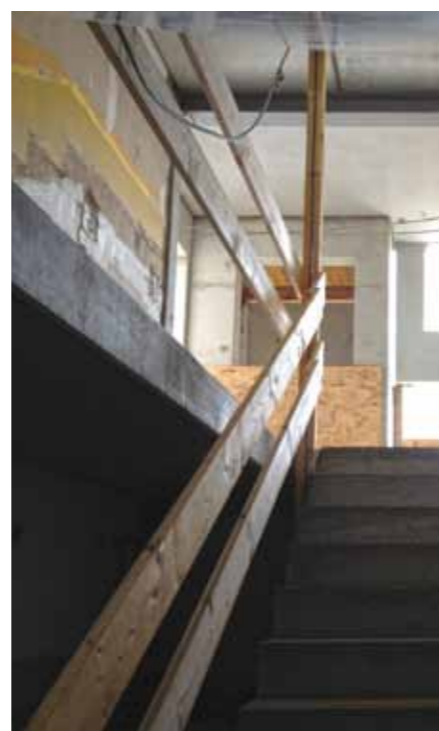
Ein Blick in die neuen Treppenhäuser zeigt, dass der Zugang zum Fahrstuhl direkt auf der Etage erfolgt
