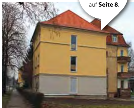
Das Haus Am Sommerbad 24 gehört zu den Sanierungsvorhaben 2019
