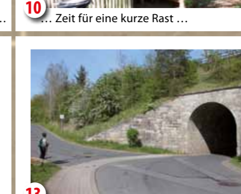
13 ... durch den Bahntunnel und die B92 ...
