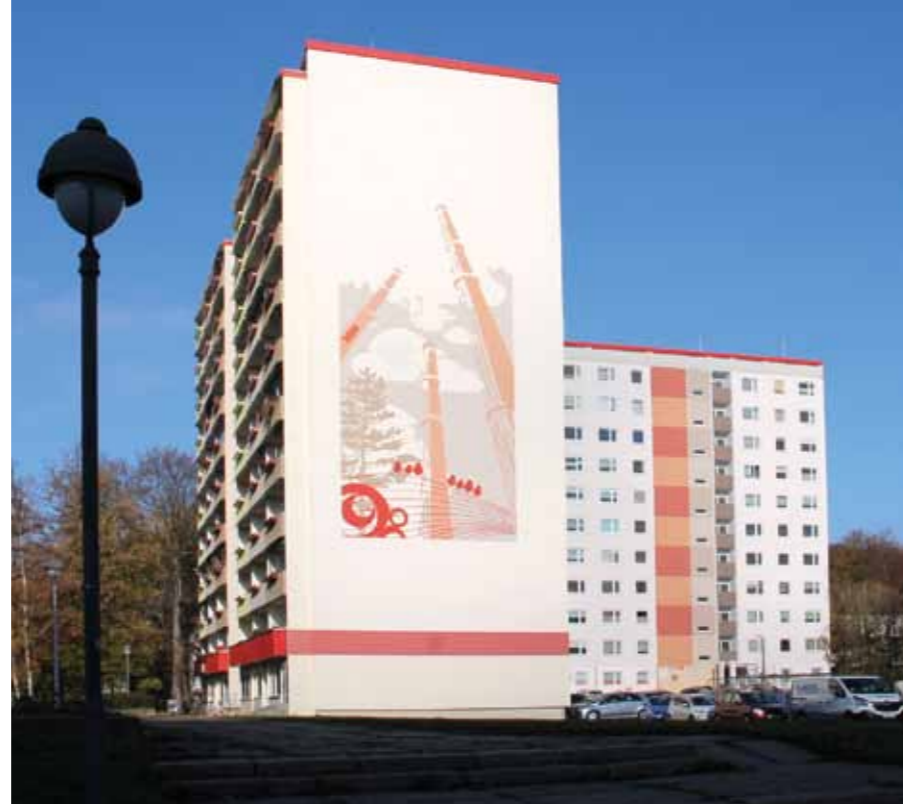
Harmonisch wirkt die Farbgestaltung nach der Sanierung der rückwärtigen Fassade
