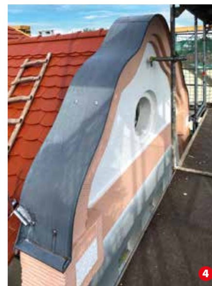
Bild 1: Das Dach und die Fassade im neuen Glanz, Bild 2: Hoch hinaus – die Dachdeckung der Firma Dinger, Bild 2 + 3: Die Dachgauben wurden wärmegeklämt und die Mauerwerkssimse im Dachbereich neu verblendet
