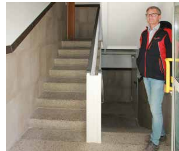
„Glück Auf“-Bauleiter Olaf Kalläne öffnet die Tür zu einem frisch sanierten Treppenhaus in der Dr.-Theodor-Neubauer-Straße. Die neue Brandschutztür ist bereits eingebaut.
